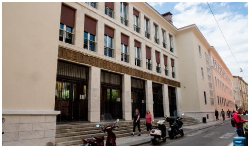
Via le impalcature, la sede centrale del Maffei ha un altro aspetto dopo i restauri FOTO MARCHIORI
