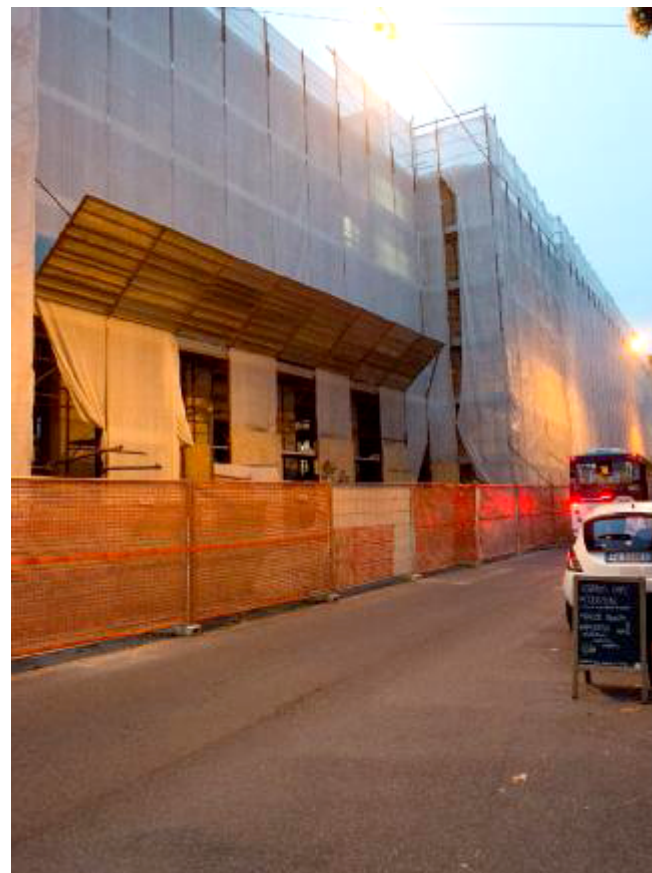
Il liceo Maffei ancora «prigioniero» del cantiere FOTO MARCHIORI
